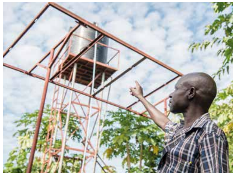
Sydsudan. Med modern teknik blir livet enklare även i Sydsudan. På några platser där de borrar som vi har borrar ger särskild god tillgång på vatten, pumpas vattnet upp till en cistern – med hjälp av solenergi! Den som kommer för att hämta vatten behöver bara vrida på kranen. FOTO: TORLEIF SVENSSON
